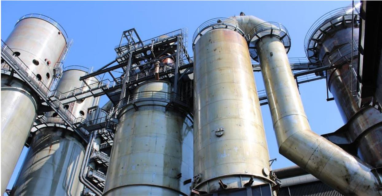
*Blick auf die Cowpers (Wärmerückgewinnungsanlagen) und die Gasreinigung des Hochofens A in Belval.*
