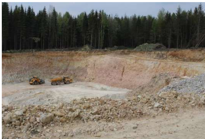
Carrière pour l'extraction de gravier de quartz à Landscheid. Les couches de mort-terrain ont des couleurs différentes en raison de la présence de composés de fer dans les couches supérieures du sol, qui pénètrent en profondeur avec l'eau, mais sont retenus par de fines particules d'argile et ne passent pas plus loin.
