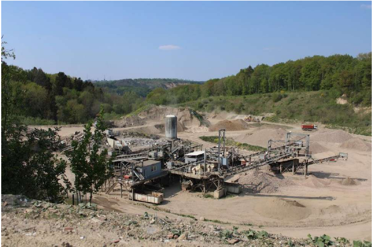
Recynam – site de recyclage de déchets de construction et démolition à Lives-sur-Meuse.
